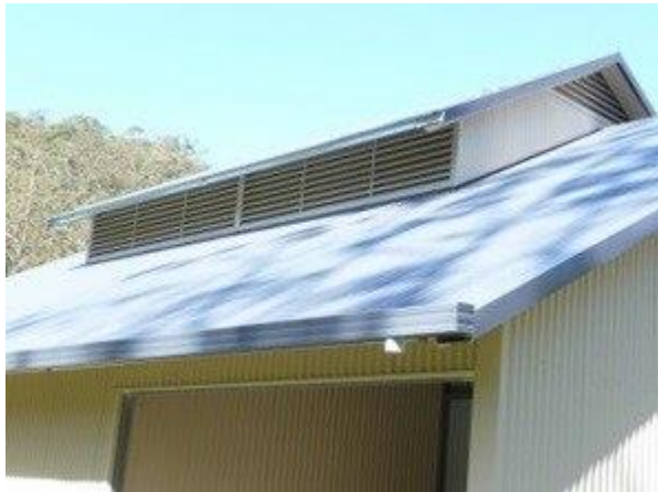
Рисунок 2 – Характерные отверстия для горизонтальной вентиляции
